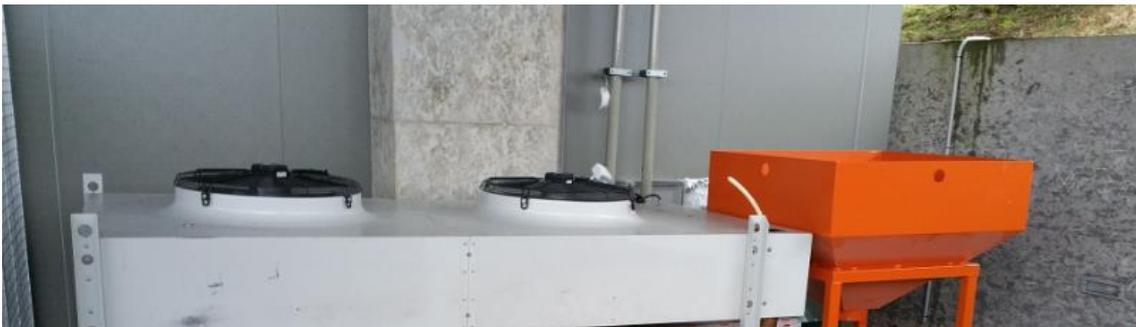
Figura 2. Aerorefrigerador (izquierda) y silo de biomasa (derecha).
